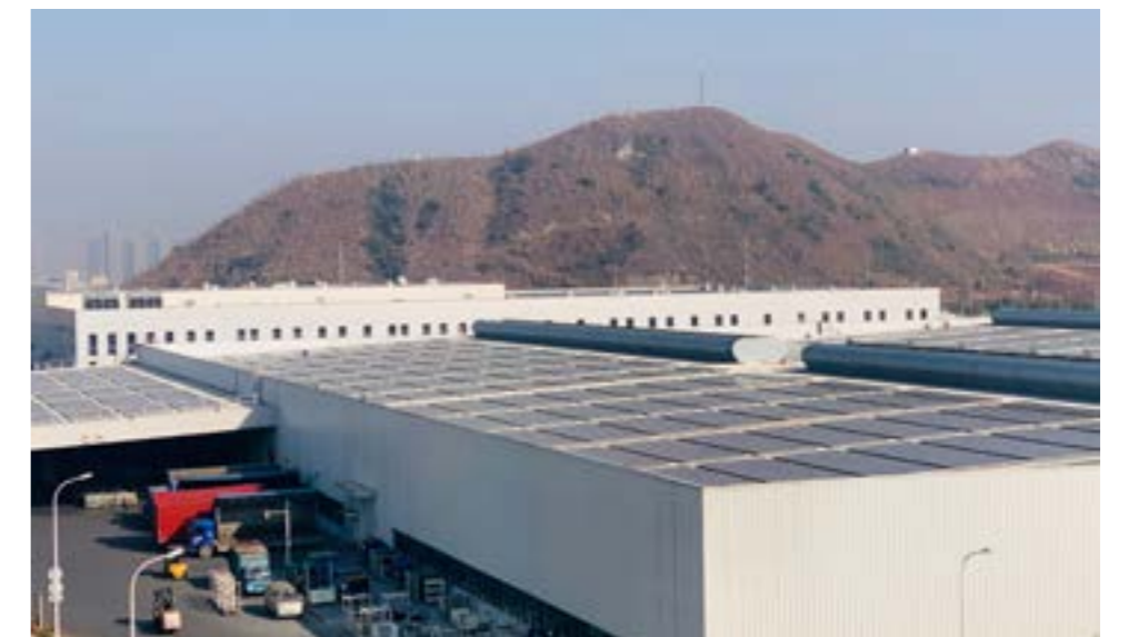
东风柳州汽车有限公司柳东基地光伏发电
